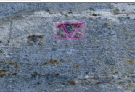
Les chaînes d'angle en besace, de la nef, sont réalisées avec des blocs de calcaire, boutisses et panneresses. Sur celle de l'angle Sud-Est, la date de 1780 y est gravée.
