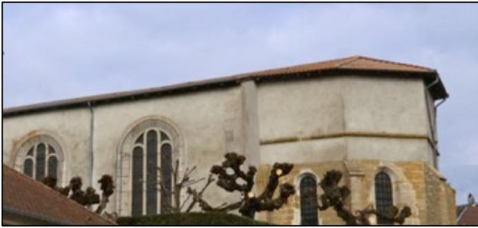
La couverture en tuiles, tige de botte, de la nef et du chœur, a été remplacée, en août 1964, par des tuiles mécaniques de Jeandelaincourt.
